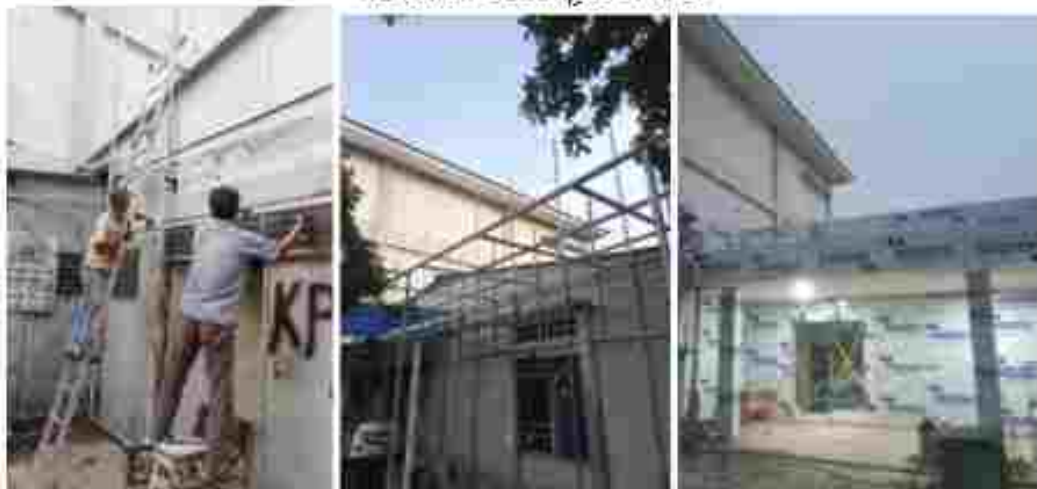
Gambar II.1 Renovasi Gedung SAR KPLP
