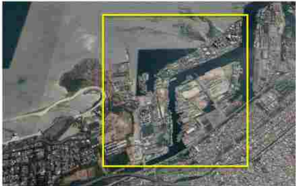
Gambar 4 Lokasi Terminal Zona Kali Japat
