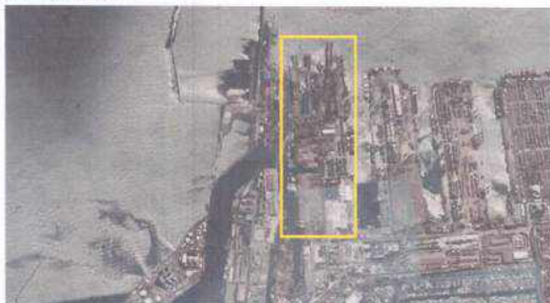
Gambar 19 Lokasi Terminal Birai I
