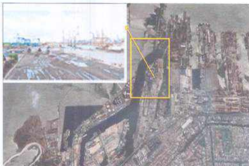
Gambar 17 Lokasi Terminal Zona Nusantara
